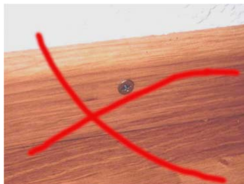
Beispiel: Massivholzfußleiste mit Kreuzschraube
